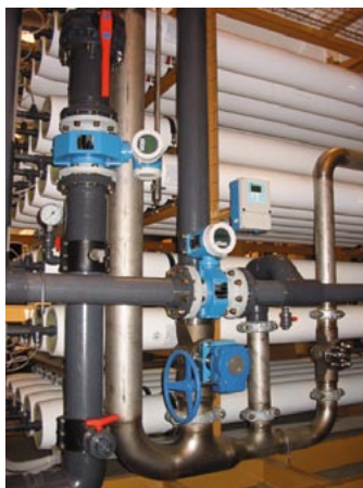
Figura 32. Detalle de las cajas de presión. Por cortesía de AQUAESPaña
